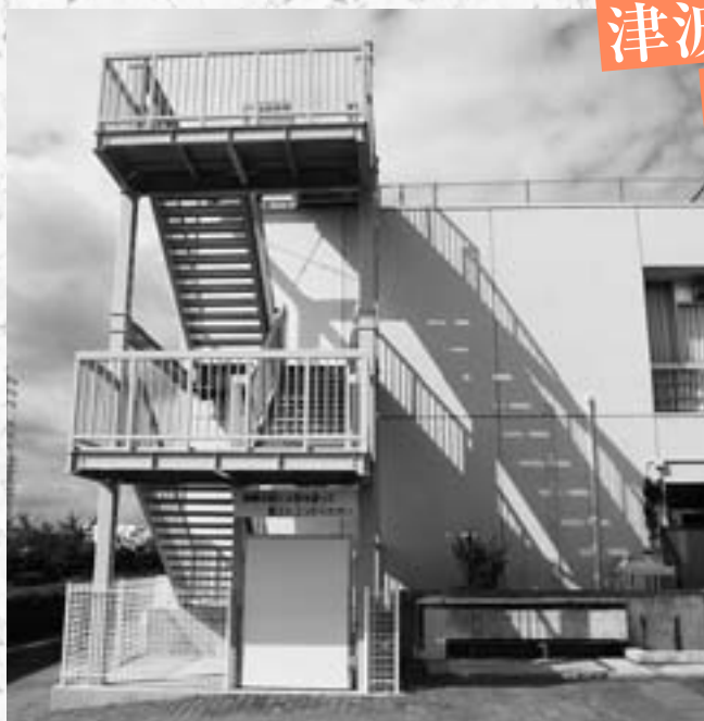
御園中学校に設置された外付け階段
